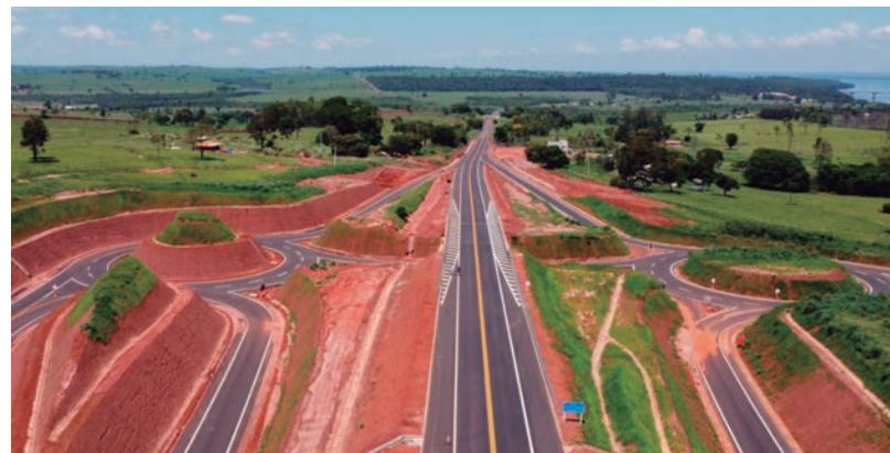
Obras do PAC no Paraná/DER
