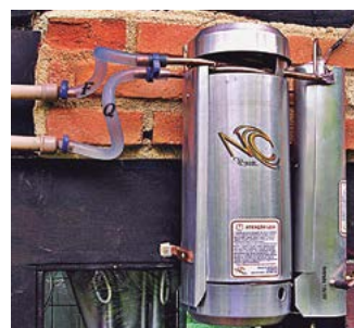
Chuveiro NR com instalação de aquecedor na área externa.
