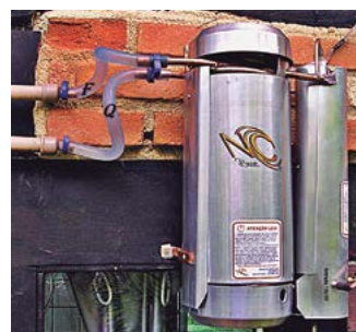
Chuveiro NR com instalação de aquecedor na área externa.
